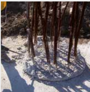
Entfernen von überstehendem Beton und Reinigung der Oberfläche
