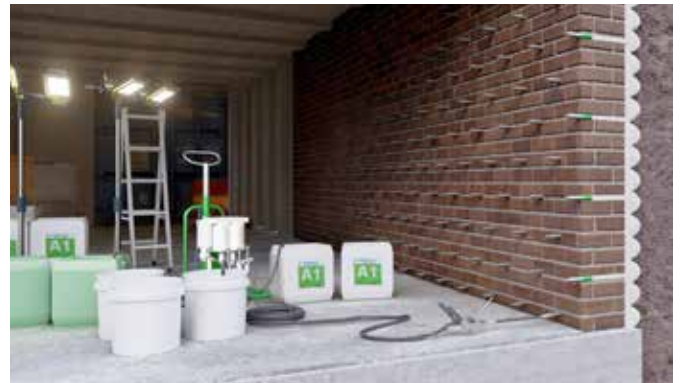
Mauerwerk Schleierinjektion
