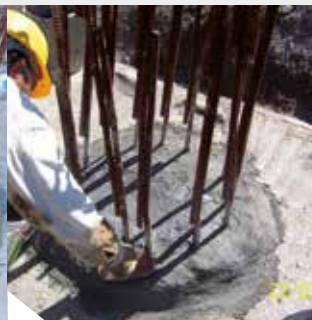
Abdichtung des Pfahlkopfes mit KÖSTER NB 1 grau
