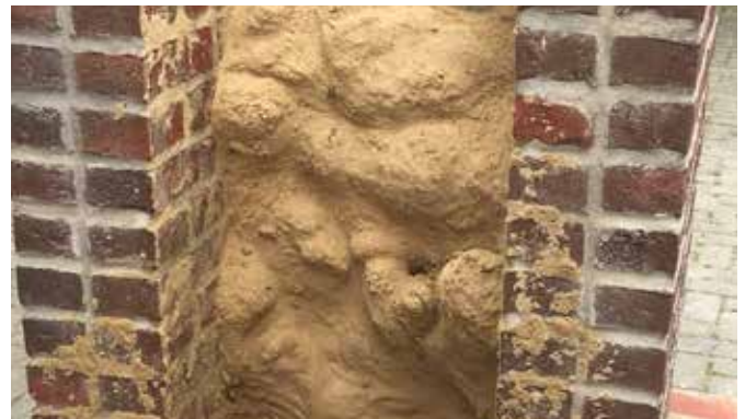
Schleierinjektion (rückseitige Ansicht)
