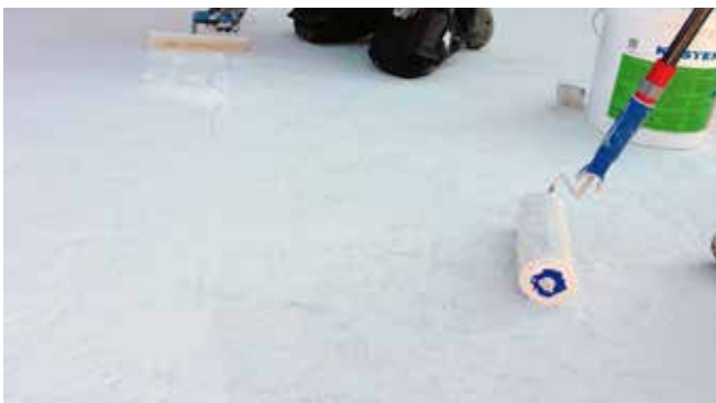
Auftragen der zweiten Lage KÖSTER 21
