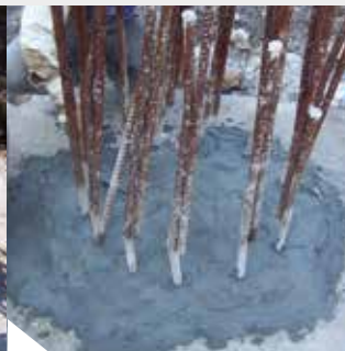
Ausarbeitung einer Hohlkehle und Ausgleichen der Oberfläche mit KÖSTER Sperrmörtel WU
