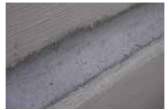
Ausgerundete Hohlkehle aus KÖSTER Sperrmörtel WU
