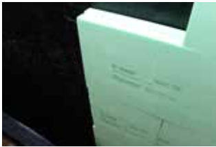
Mit KÖSTER Deuxan 2K-Spachtel-dicht lassen sich Dämmplatten leicht an der Abdichtung befestigen. Wichtig ist dabei eine vollflächige Verklebung.
