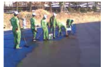
Abdichtung mit KÖSTER Deuxan 2K-Spachteldicht
